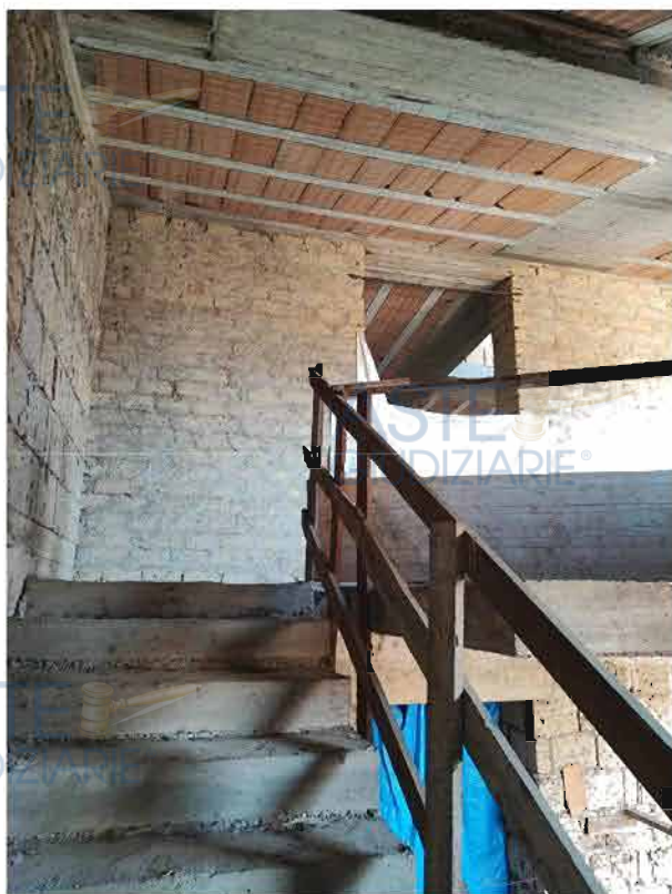
Scala d'accesso al piano sottotetto
