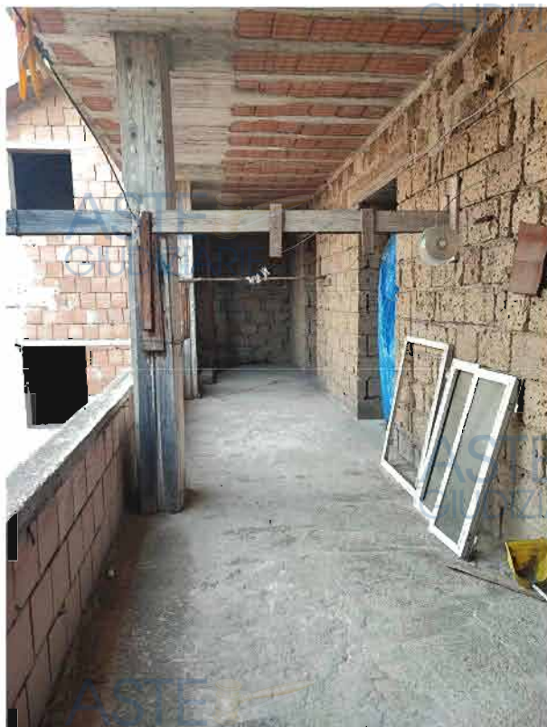
Ballatoio del 1° piano (altra vista)
