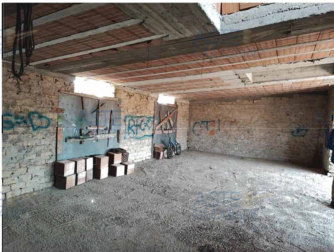
Vano 4 (altra vista)
