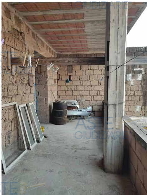
Ballatoio del 1° piano
