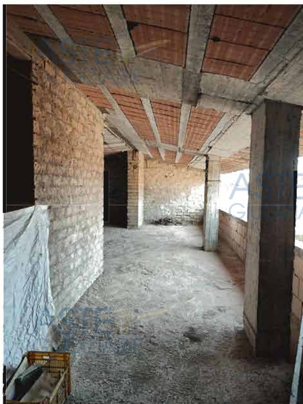
Ballatoio del piano sottotetto
