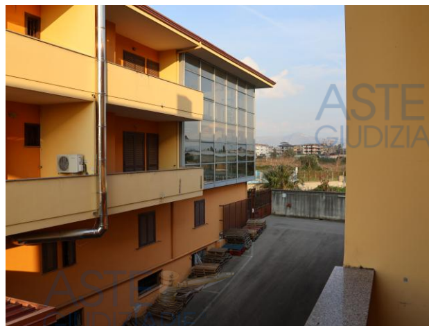
Rampa di accesso ai garage
