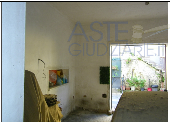
Foto 7 - locale al piano terra adibito a garage
