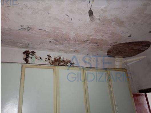
*Infiltrazione dal soffitto con distacco intonaco e formazione di muffe*
