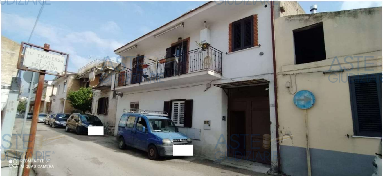
Foto 1 – appartamento al primo piano di via Bolzano, prospetto ovest.
