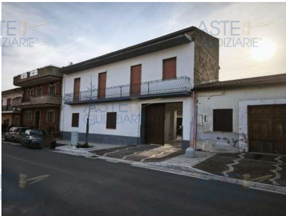
VISTA DEL FABBRICATO DA CORSO IV NOVEMBRE
