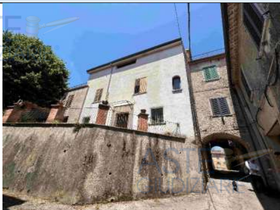
Vista esterna fabbricato
