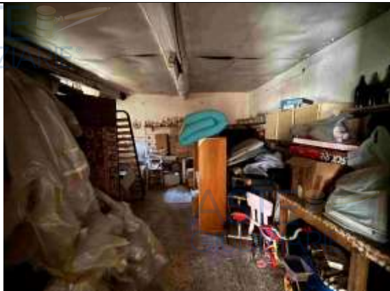
Vista interna locale terraneo sub 9
