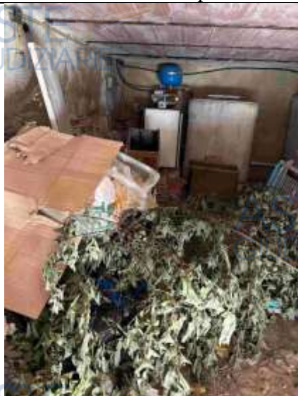
Interno locale p.la 239 sub 3
