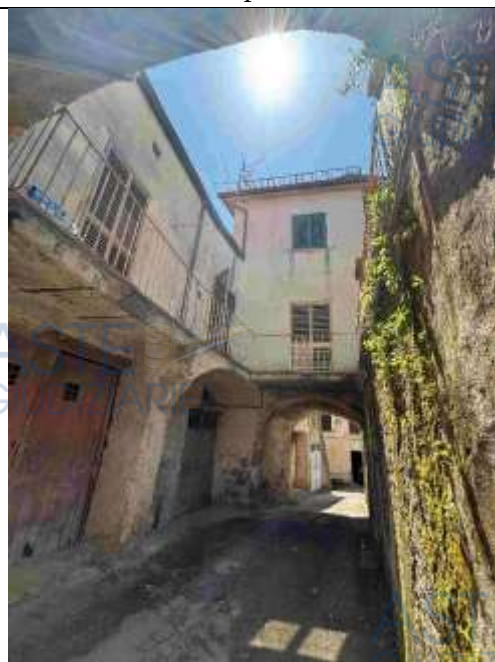
Ingressi locali terranei da via Municipio
