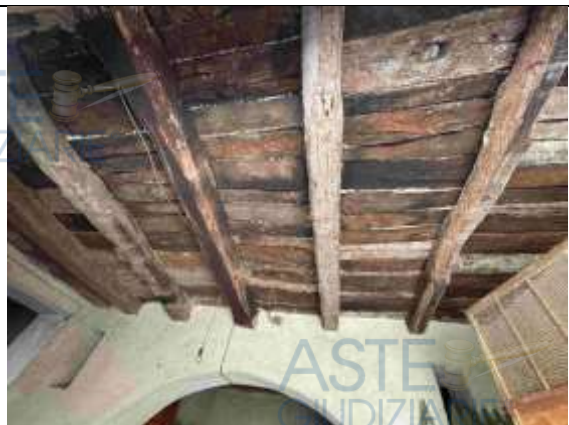
Particolare solaio locale terraneo sub 10
