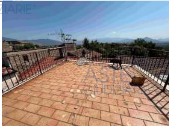
Terrazzo piano terzo, p.lla 239 sub 2
