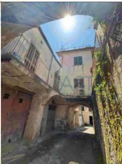
Vista esterna fabbricato
