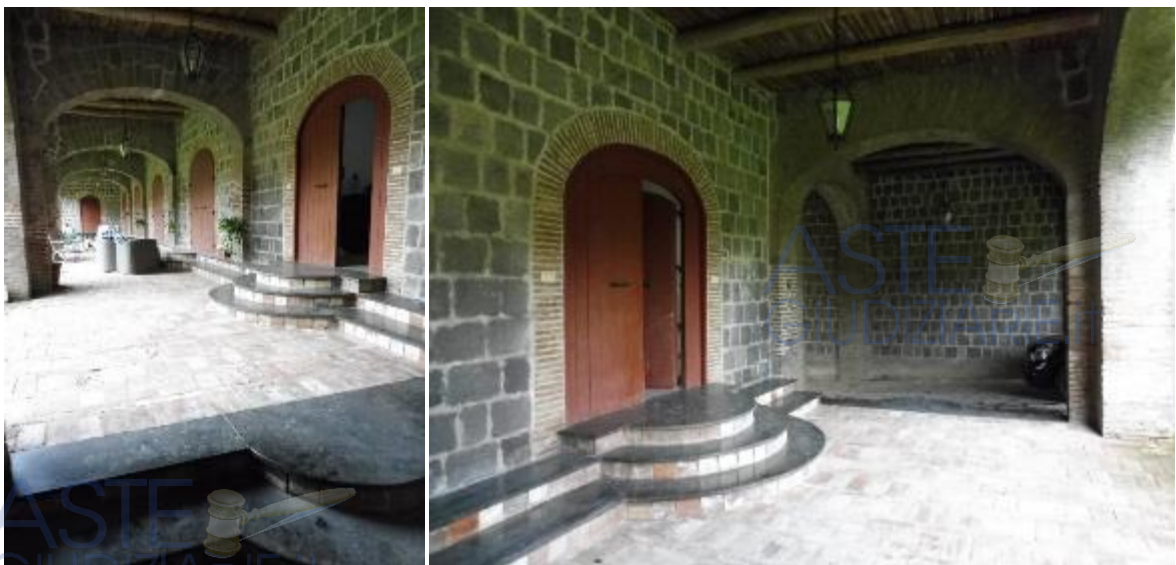
_androne e accesso al vano scala
