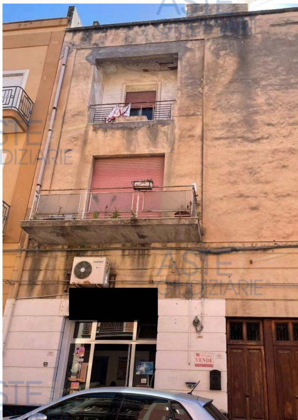
Foto n. 1 – Vista prospetto principale via R. Morandi 50 A
