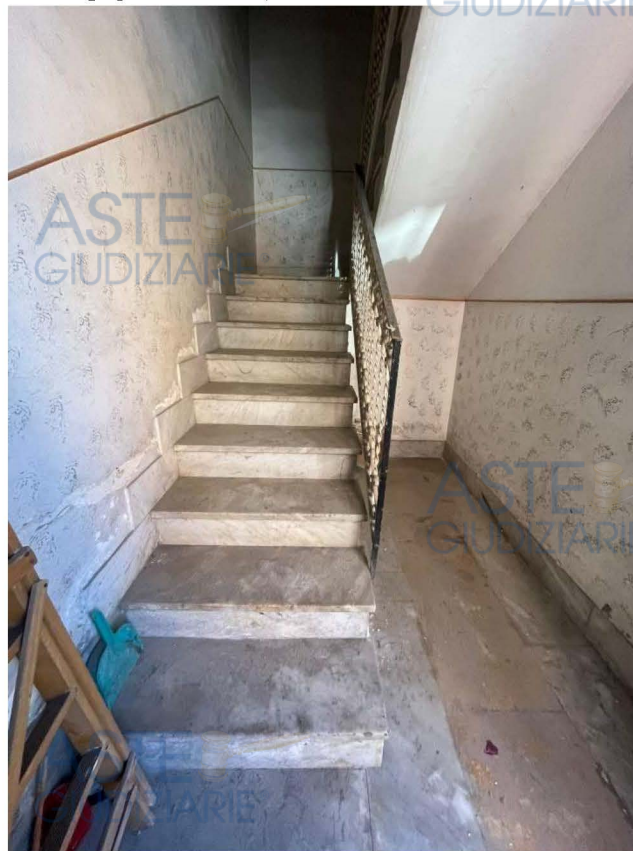
Foto n. 12 – Vista scala interna per accedere al 1° piano
