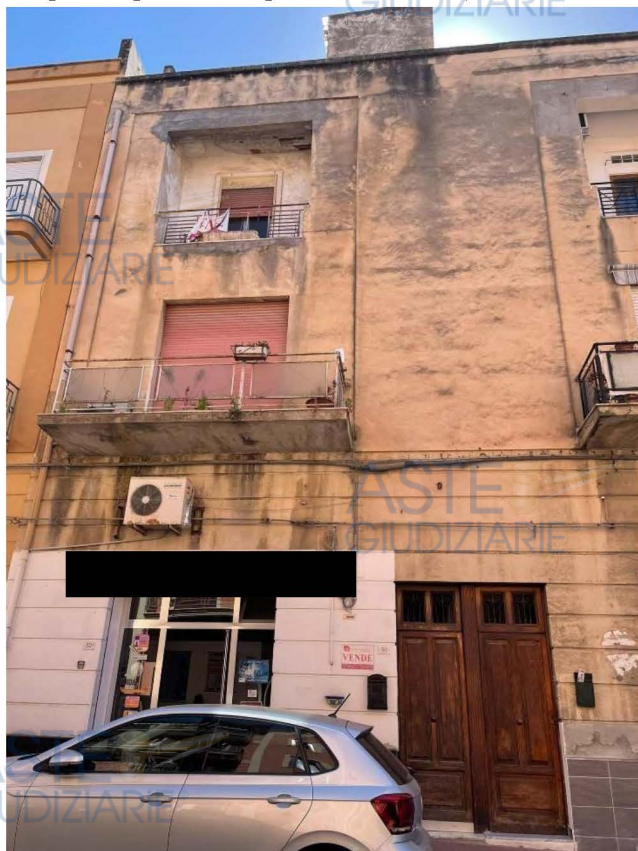
Foto n. 11 – Vista prospetto principale via R. Morandi 50
