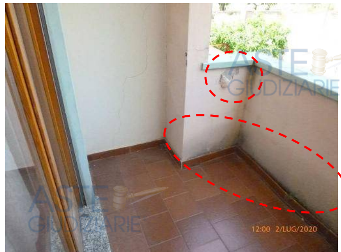
Foto 134 e 135 – Balconcino del bagno, sul fronte nord, caratterizzato da pavimentazione in condizioni discrete, parapetto in muratura con alcuni punti che presentano distacchi di intonaco e tracce di umidità.
