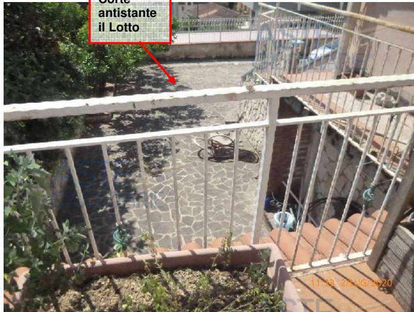
Foto 104 e 105 – Vista dalla porzione del terrazzo nella zona laterale, con affaccio sulla corte antistante il corpo di fabbrica.
