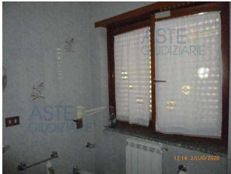
Foto 112 – Finestra del bagno, con particolare del rivestimento dalla gradazione chiara.
