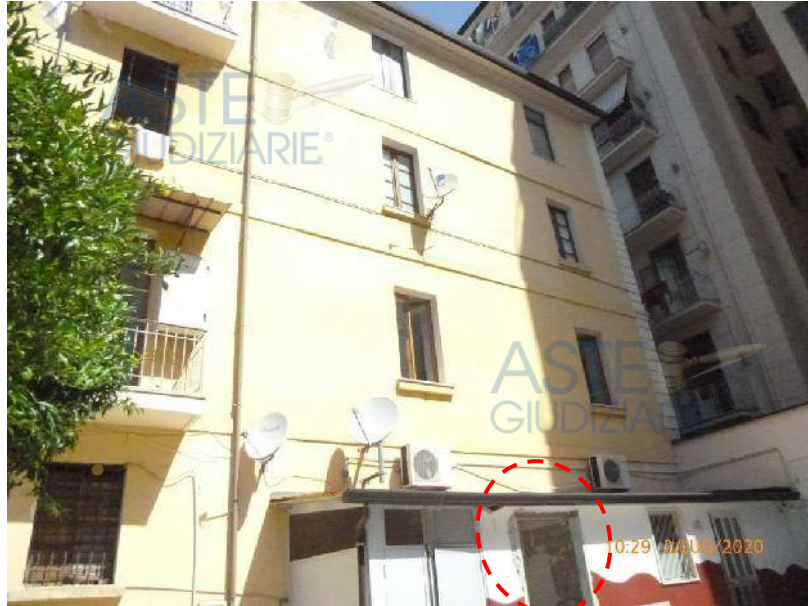
Foto 8 – Varco d'accesso all'area scoperta adiacente al Lotto in oggetto inquadrato dal Lotto stesso; si noti il fabbricato in cui è ubicato il locale commerciale, dai prospetti di colorazione chiara, con affacci sulle corti, una delle quali afferente al Lotto n. 1.
