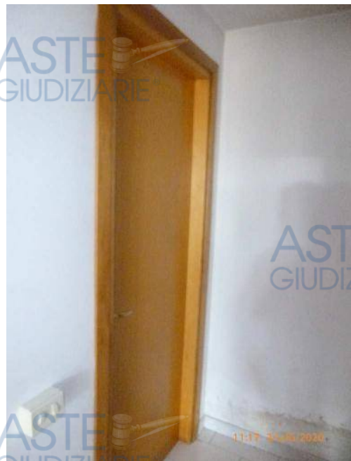
Foto 81 e 82 – Ulteriore vista dell'autorimessa in direzione della porta e la porta inquadrata dall'esterno. Si notino gli elementi strutturali in prossimità della porta.
