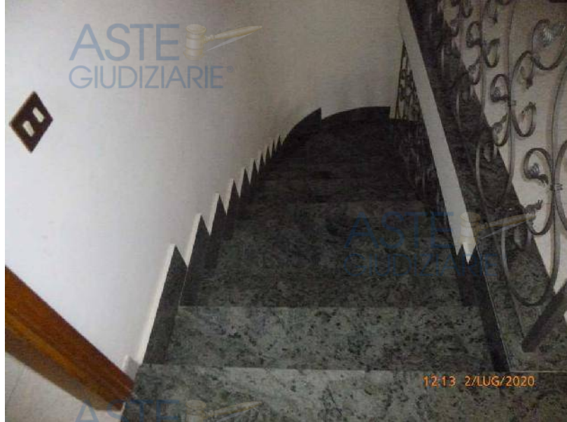
Foto 113 - Punto di arrivo della rampa proveniente dal piano primo. Si notino le finiture e la ringhiera in discrete condizioni.
