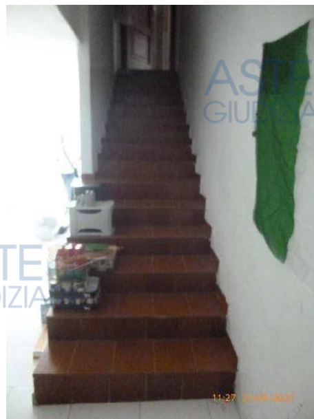
Foto 91 - Collegamento tra il locale al piano terra ed il livello superiore.
