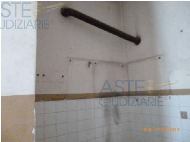
Foto 55 e 56 – Particolare della tubazione presumibilmente relativa ad una vecchia stufa utilizzata a suo tempo; si noti il confine tra l'ambiente ingresso e disimpegno, con pavimentazione differente e spessore notevole della muratura.
