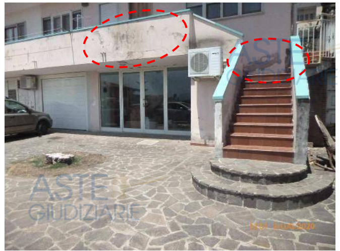
Foto 74 e 75 – Particolari del prospetto lato sud, interessato da fenomeni di infiltrazione delle acque meteoriche e rampe di accesso al ballatoio che conduce al portoncino d'ingresso, evidenziato, del Lotto in oggetto.
