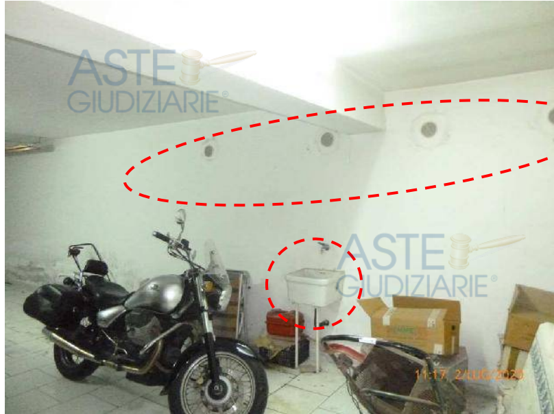
Foto 80: Vista dell'autorimessa con particolare dei fori di aerazione e del piccolo lavatoio presente.
