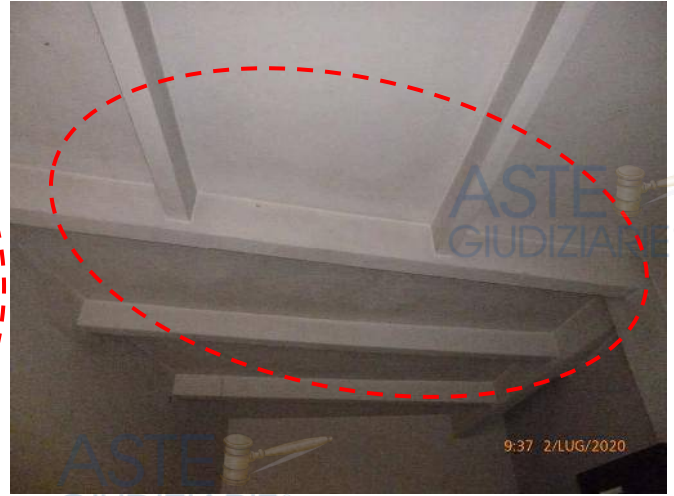
Foto 22 e 23 – Particolare del punto luce ubicato in prossimità della porta d'accesso al locale deposito e del succello dello stesso locale, caratterizzato dalla presenza di travi a vista. Si notino le vistose tracce di umidità presenti in più punti del Lotto nella foto di sinistra.
