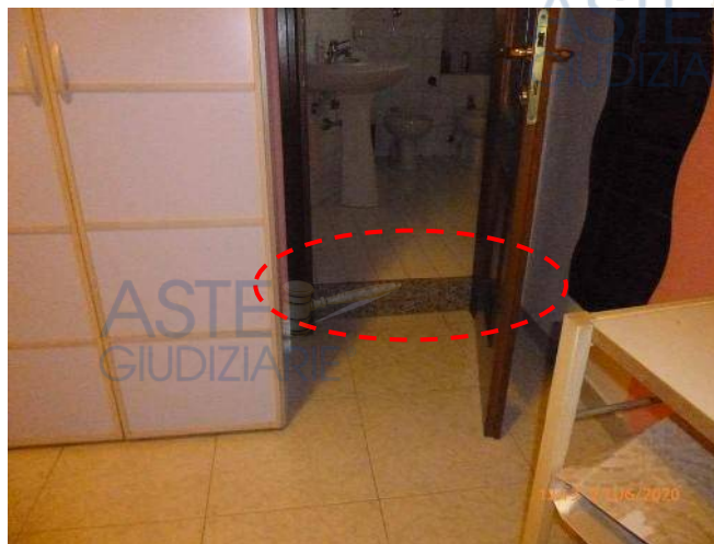
Foto 120 e 121 – Nicchia in cui è ubicato il piatto doccia del bagno di pertinenza. Si noti il gradino dovuto a ragioni impiantistiche presente all'ingresso del vano.
