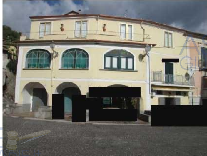
Foto 1: Prospetto del fabbricato in cui è ubicato il lotto staggito.
