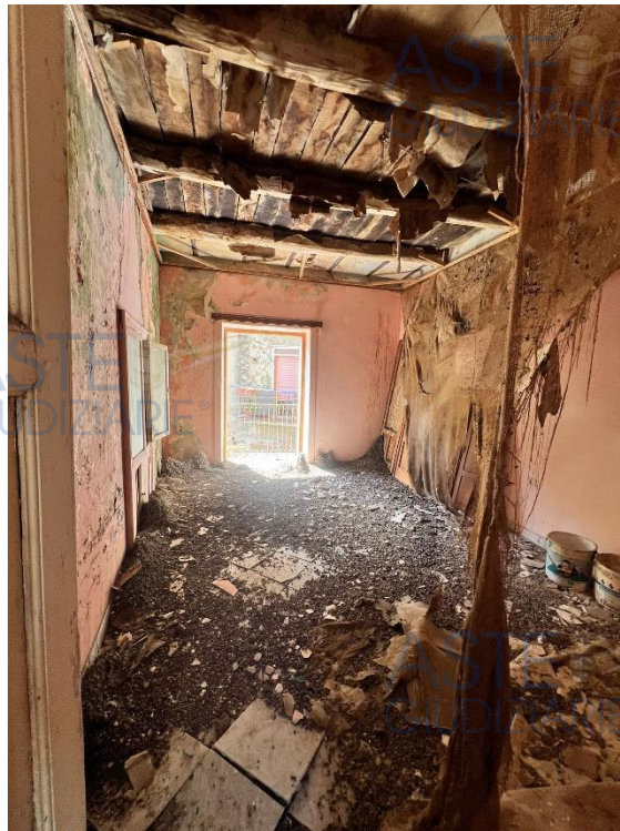
Foto 5 – Vista degli interni dell’Abitazione: si notino in particolare i solai in legno su cui intervenire, anche sotto il profilo strutturale.
