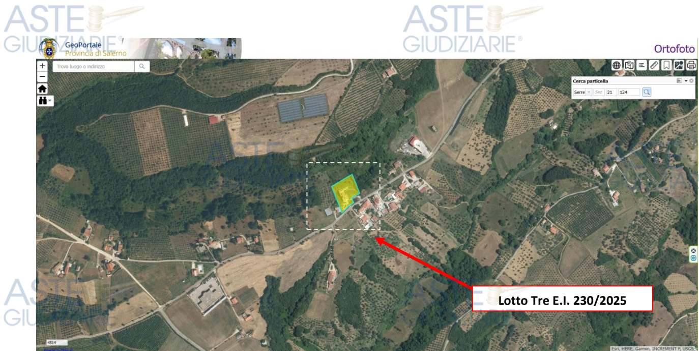
Fig. 32: ortofoto di inquadramento su piccola scala, con individuazione della particella 124 contenente il cespite esecutato, Lotto Tre, sito in contesto extraurbano di via San Bernardino del comune di Serre (fonte: Google Maps). Si noti la vocazione prevalentemente agricola del contesto.
