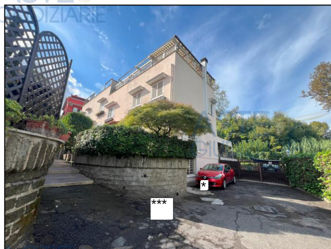
Vista esterna del fabbricato
