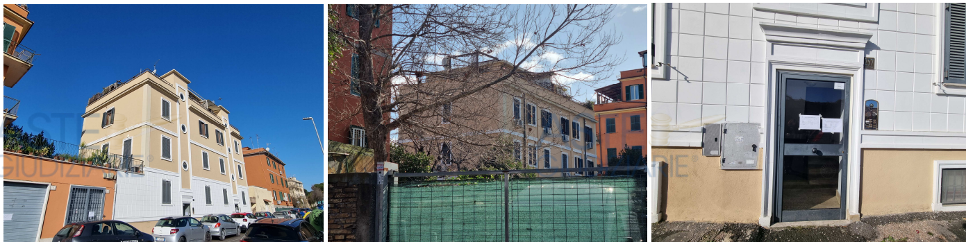
VISTA ESTERNA FABBRICATO
