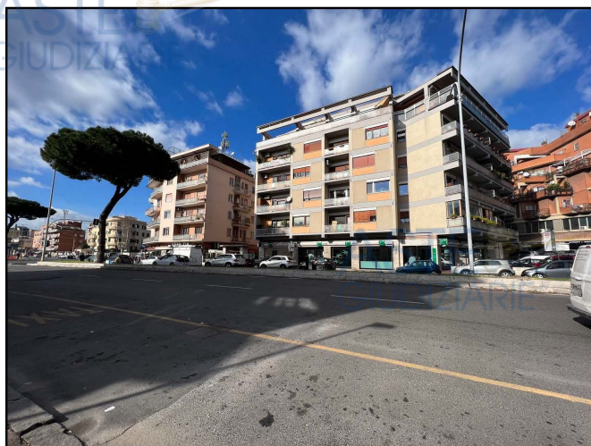
Vista del fabbricato su Via Aurelia
