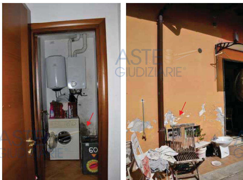
Macchie di umidità e intonaco esterno danneggiato
