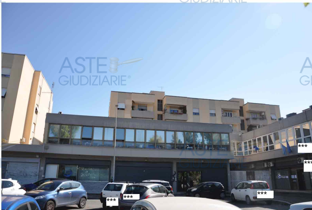
Edificio in esame
