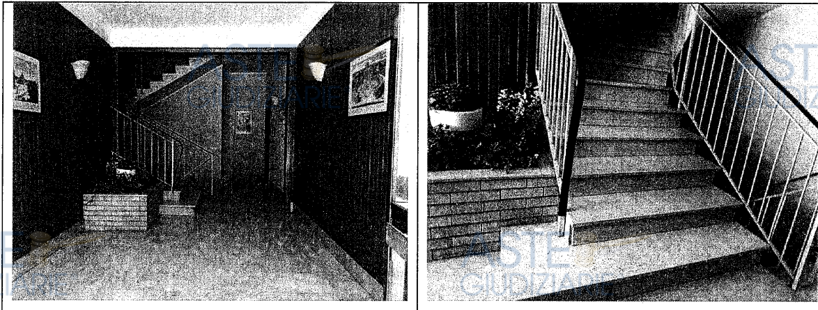
Figura 5 – Atrio di ingresso e vano scala
