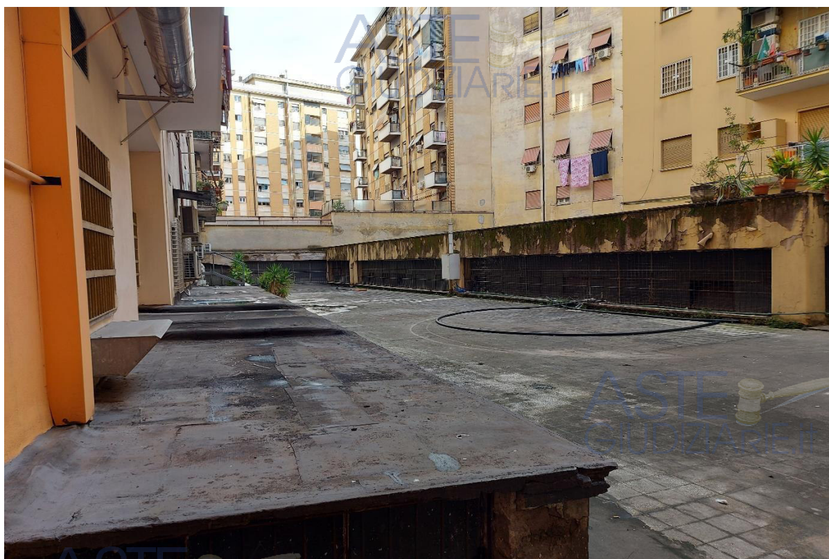
Corte condominiale – finestre alte
