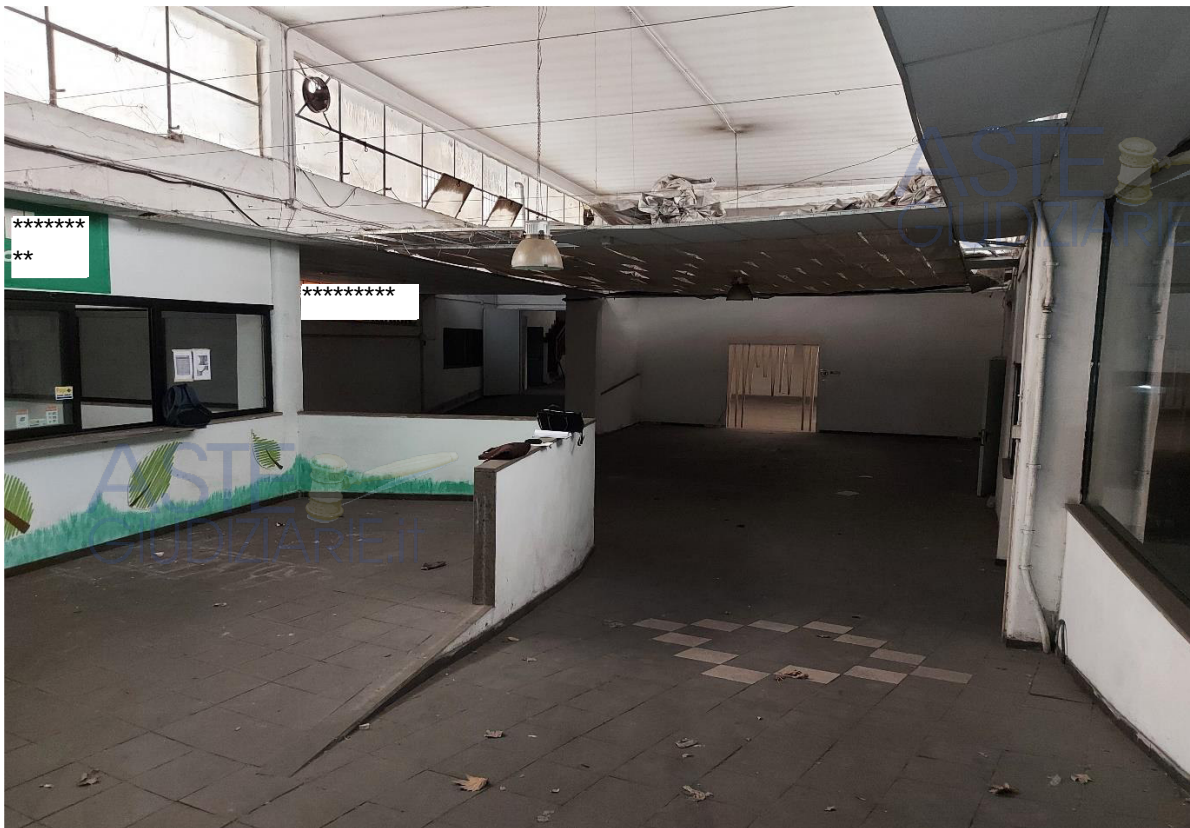
Da rampa via Casal Bertone verso locale 1
