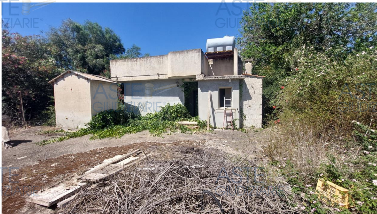
Foto 03. Prospetto principale immobile con evidente sterpaglie
