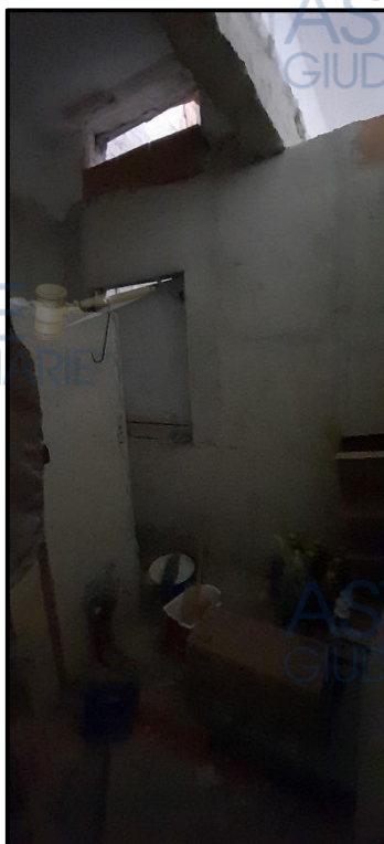
Foto n° 10: Vista interna del W.c. appartenente all'unità immobiliare in oggetto.
