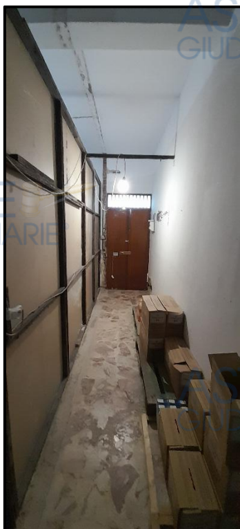
Foto n° 9: Vista interna del vano 2 appartenente all'unità immobiliare in oggetto.
