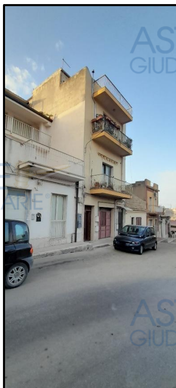
Foto n° 6: Vista assonometrica della Via Cesare Battisti dove risiede il fabbricato a cui appartiene l'unità immobiliare in oggetto.
