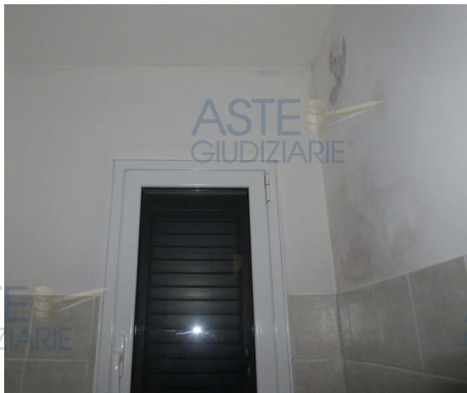
**Infiltrazione di umidità nel bagno al piano secondo con distacco dell'intonaco in corrispondenza della parete interna del bagno**
