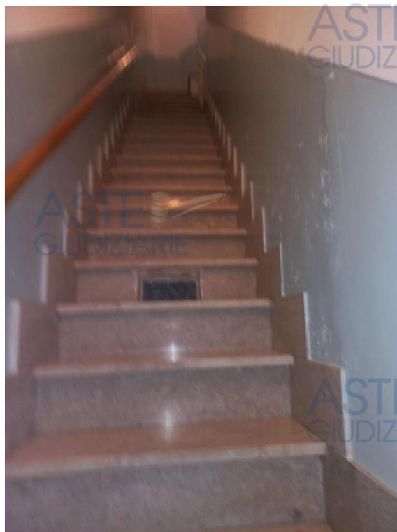
**Distacco intonaco parete causa rigonfiamento umidità nella scala interna di accesso ai piani superiori**
