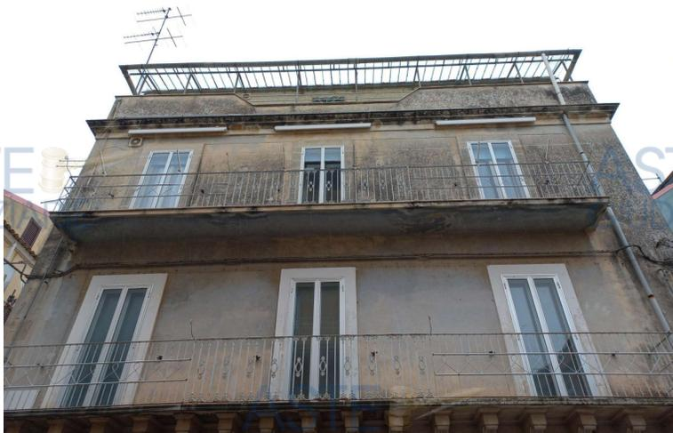
Particolare balcone del secondo piano con evidenti segni di umidità
