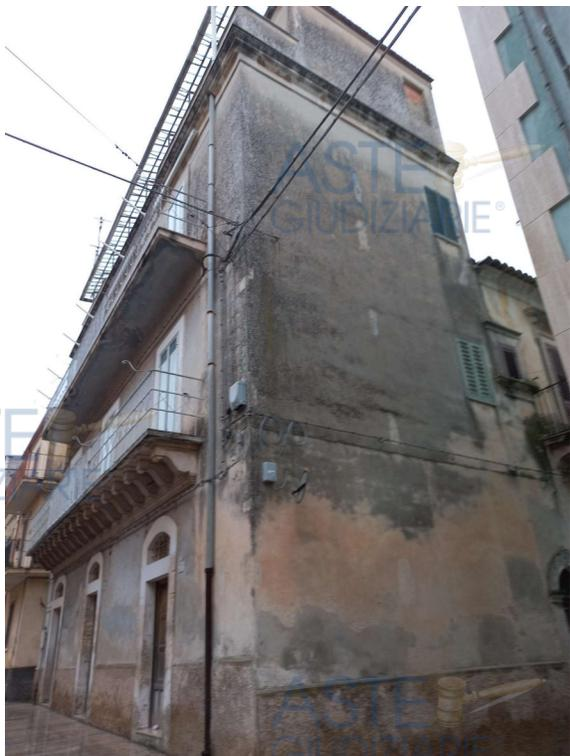
**Prospetto laterale con evidenti macchie nere di umidità lungo tutto la sua parte superiore**
