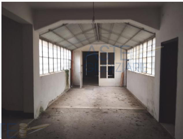
Figg. 5- 6 - Porzione con superfici vetrate e copertura in lamiera
