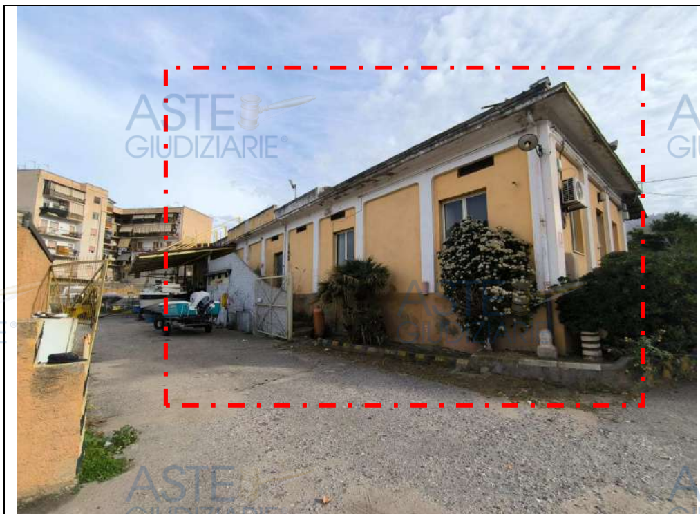
Figura n.8- Foto del corpo di fabbrica “B” ( tratteggiato in rosso)
