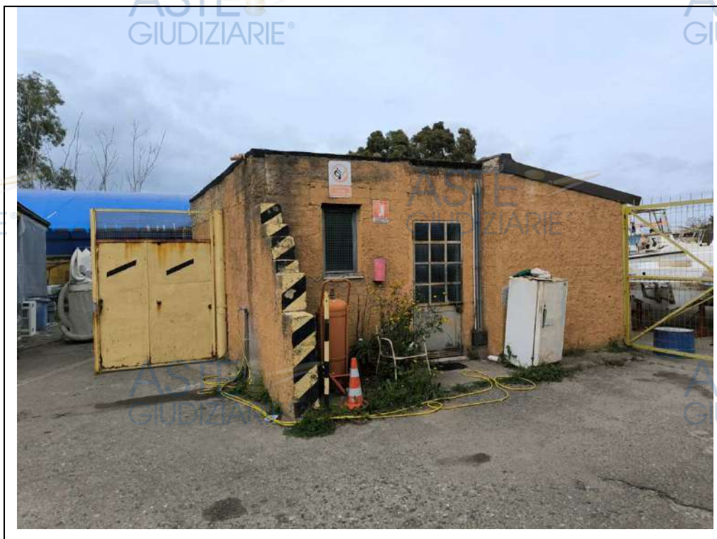
Figura n.10- Foto del corpo di fabbrica “C”
