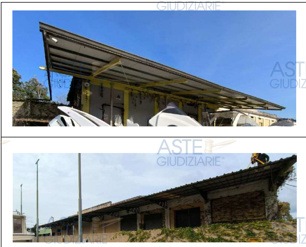
Figura n.4 – Particolare pensiline corpo di fabbrica "B" (immagine sopra pensilina lato Ovest, immagine sotto pensilina lato Est)
