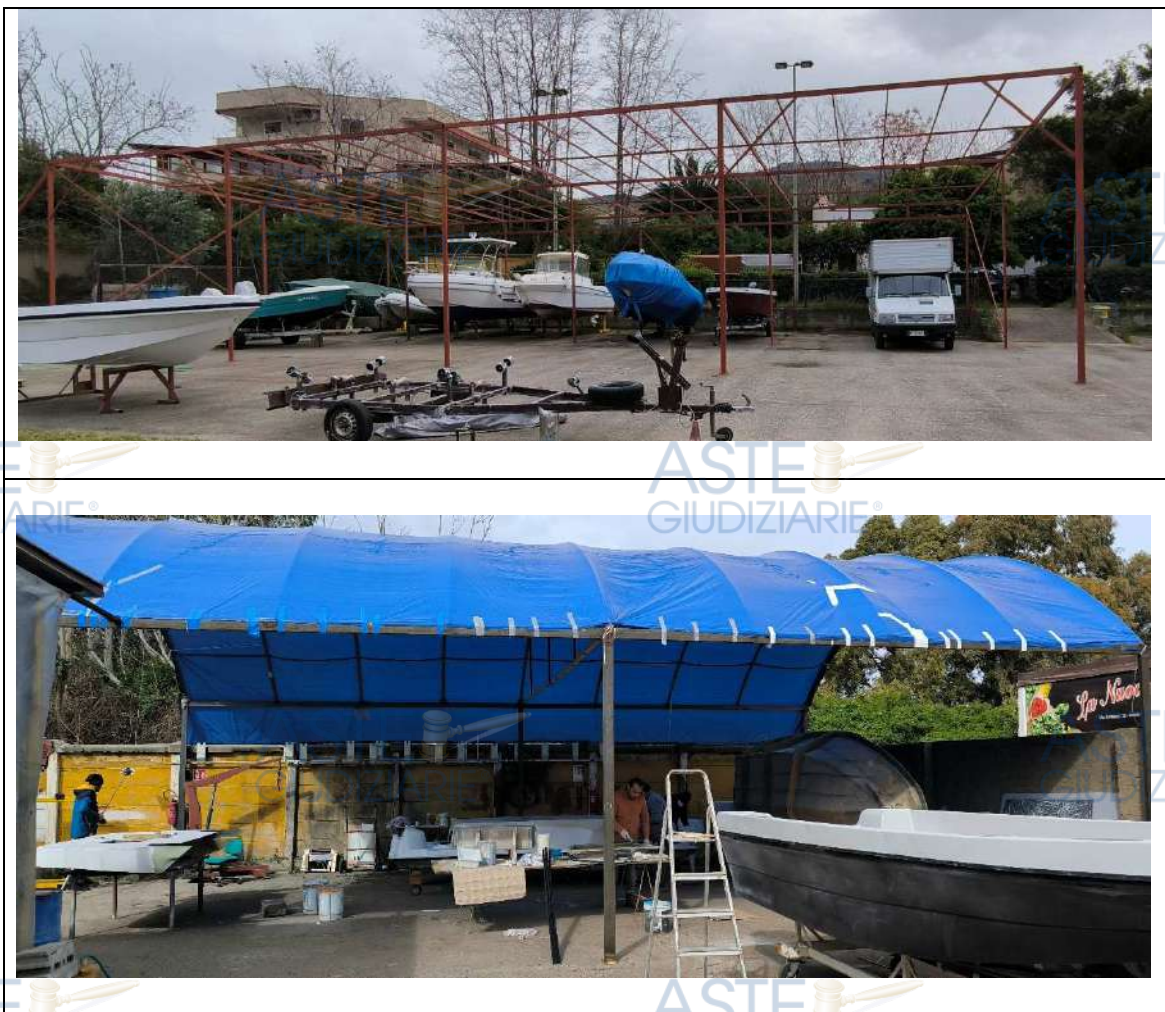
Figura n.6 – Particolare struttura metallica (4b) e capannone (4c)
