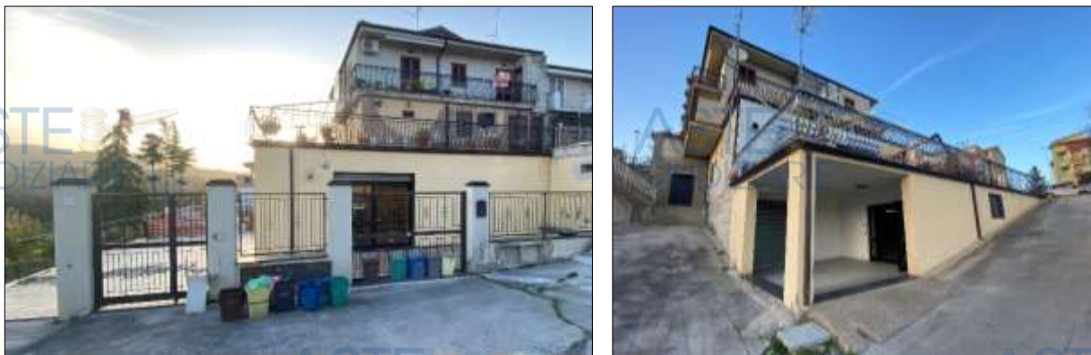
Fig. 4 – Foto degli esterni del fabbricato
