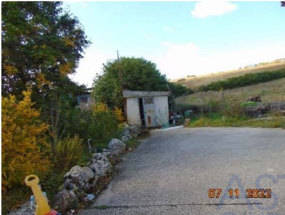
Area di pertinenza e locale tecnico
