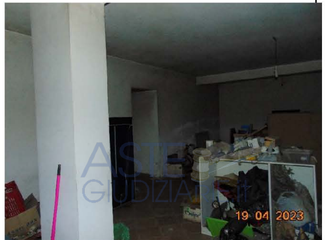
Deposito - Piano interrato
