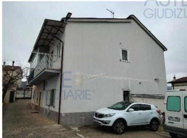
Le strutture portanti dell'edificio sono realizzate in muratura portante con solai in latero cemento.
