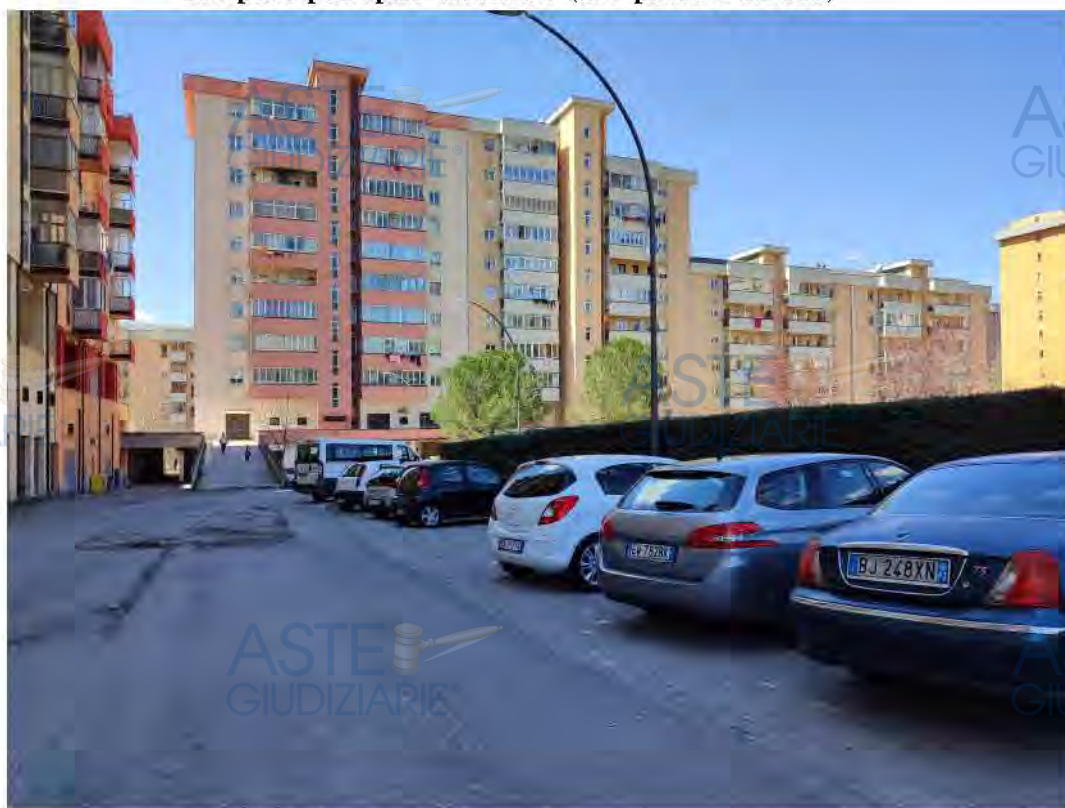
Prospetto principale fabbricato (lato piazzale S. Sofia)
