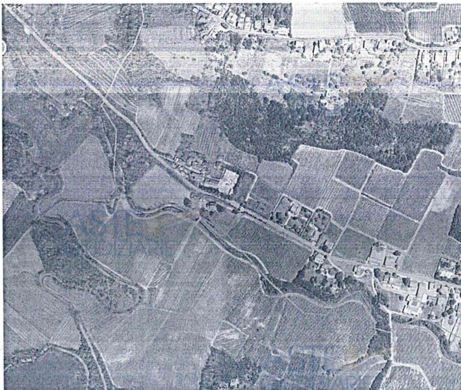
Ortofoto della zona in cui sono inseriti i lotti
