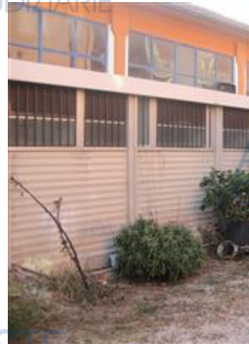
Deposito laterale realizzato a confine addossato al capannone
