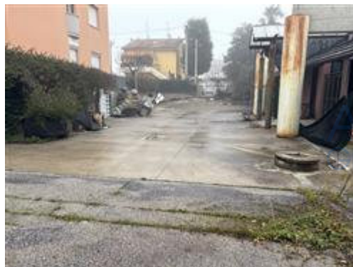
vista frontale di porzione di scoperto asfaltato comune alle due unità immobiliari(negozi e garage)
