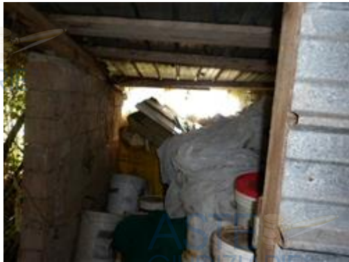
Vista interna manifatti.
