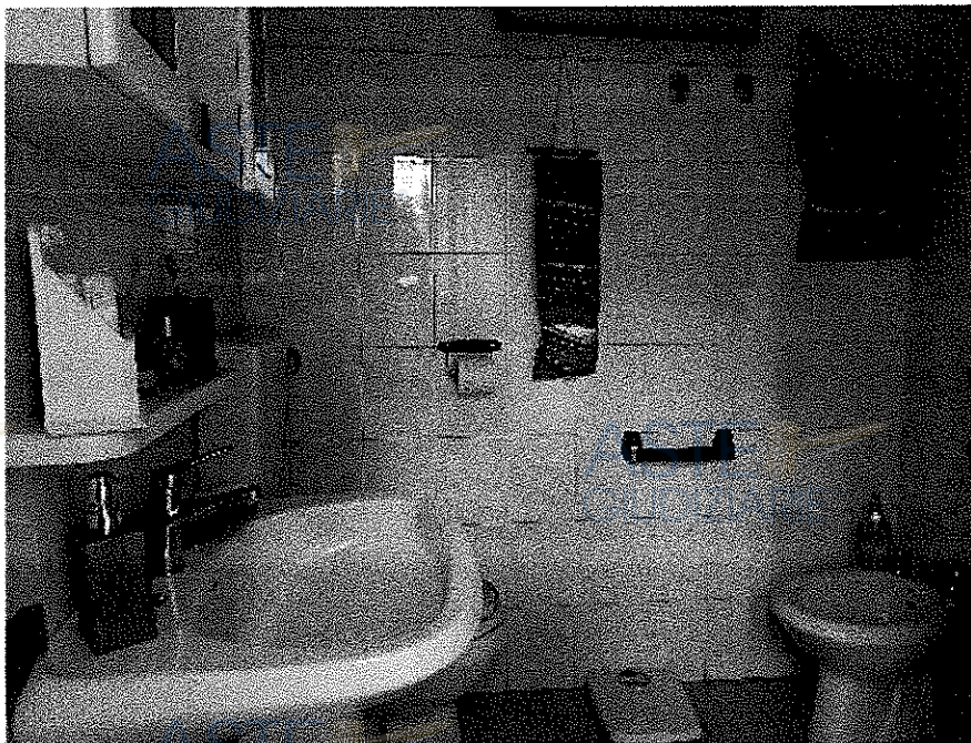
Foto n. 15 – BAGNO piano primo
