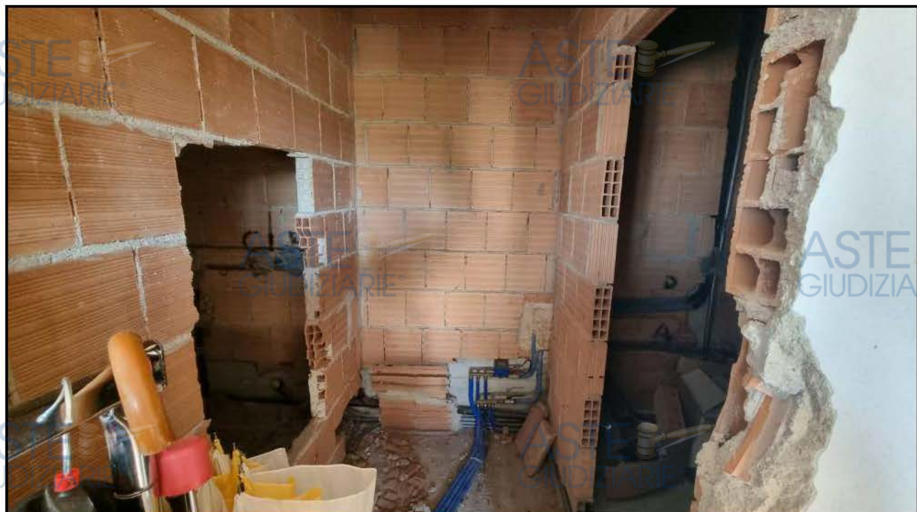
FOTO 8 - Interno - Particolare lavori sospesi scannafosso - Interno U.I. Fg. 60, P.Ila 249, Sub. 4
