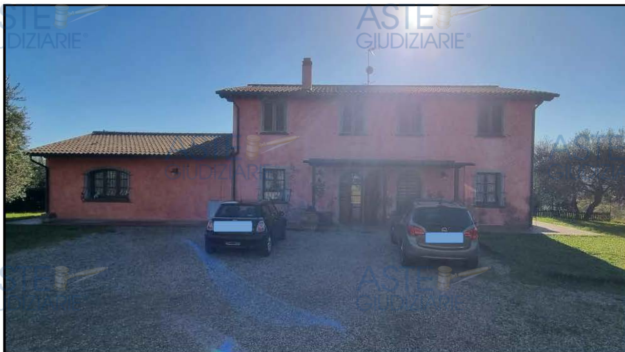
FOTO 1 - Vista Panoramica – Fronte Principale
