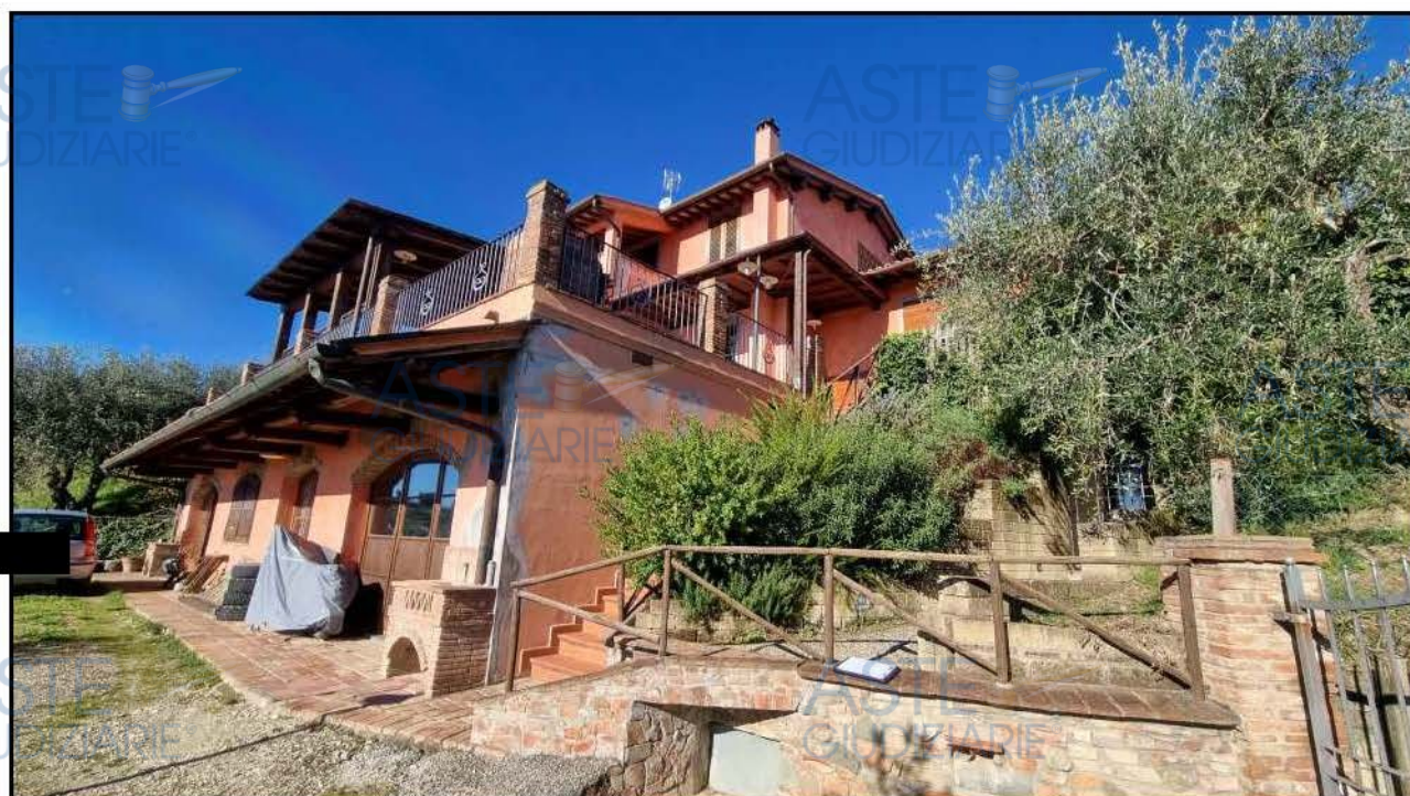
FOTO 4 - Vista Panoramica – Angolo Sud-Est – Tergo del Fabbricato e Lato Sx
