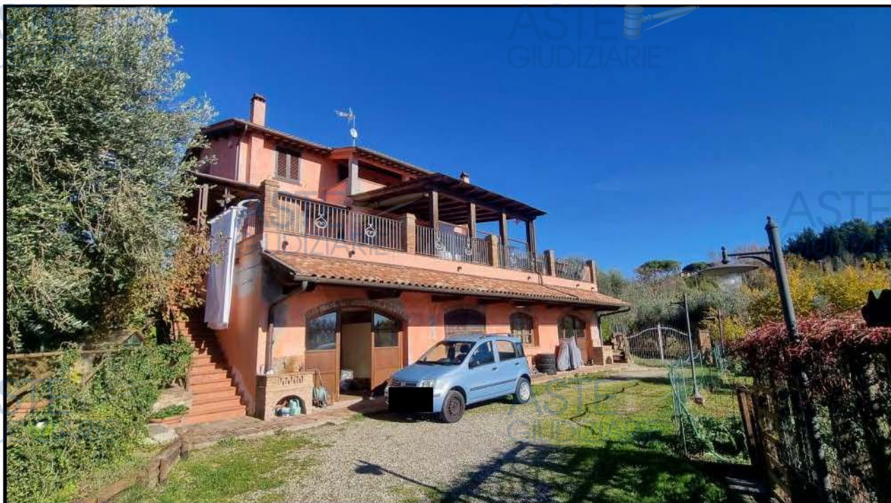
FOTO 3 - Vista Panoramica – Angolo Sud-Ovest – Tergo del Fabbricato e Lato Dx
