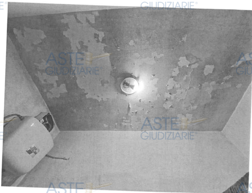
foto 2 : solaio interpiano zona bagno
