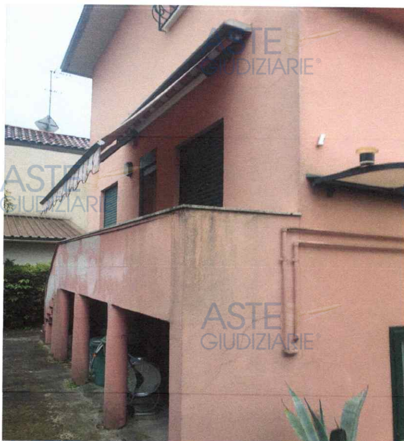
scorcio lato est dalla corte interna
