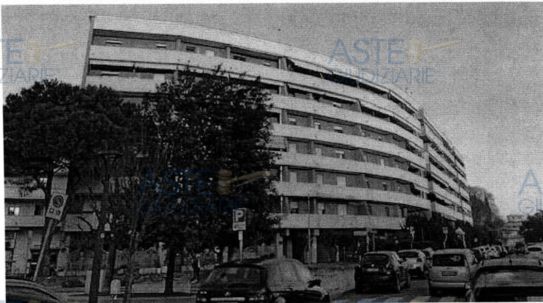
Vista del fabbricato condominiale dalla pubblica via – lato visibile nella foto è il lato ovest e sud
