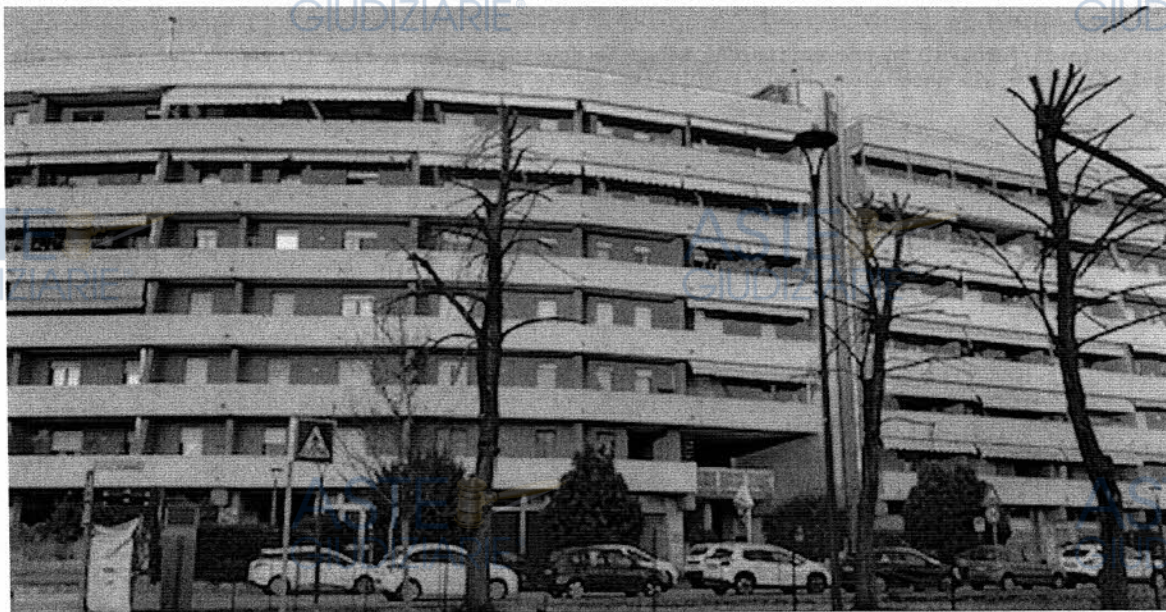
Vista del fabbricato condominiale dalla pubblica via – lato visibile nella foto è il lato sud
