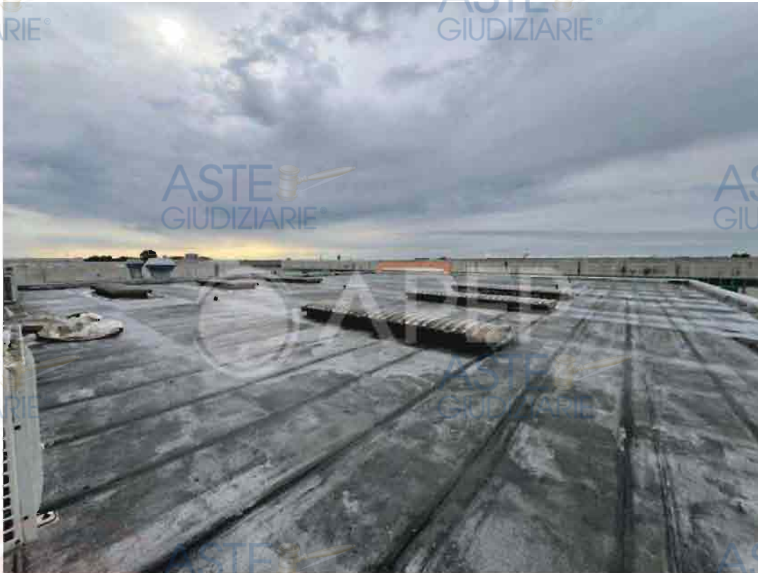
Panoramica sulla copertura da sud ovest
