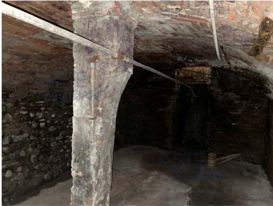
Fot. N. 22: Cantina con soffitto "a botte" a volta di mattoni pieni
