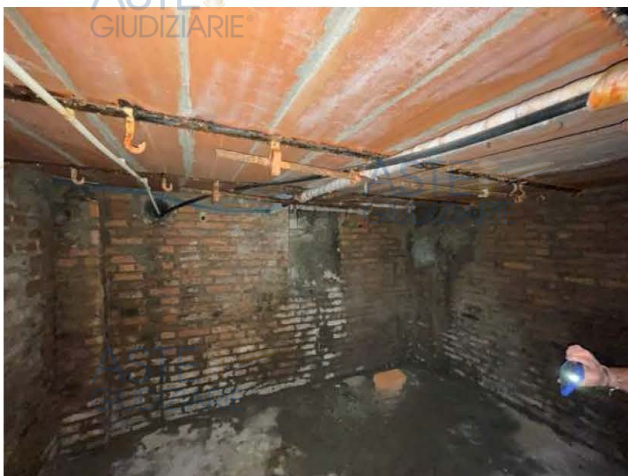
Fot. N. 21: Cantina con soffitto in putrelle in ferro e tavelloni di laterizio
