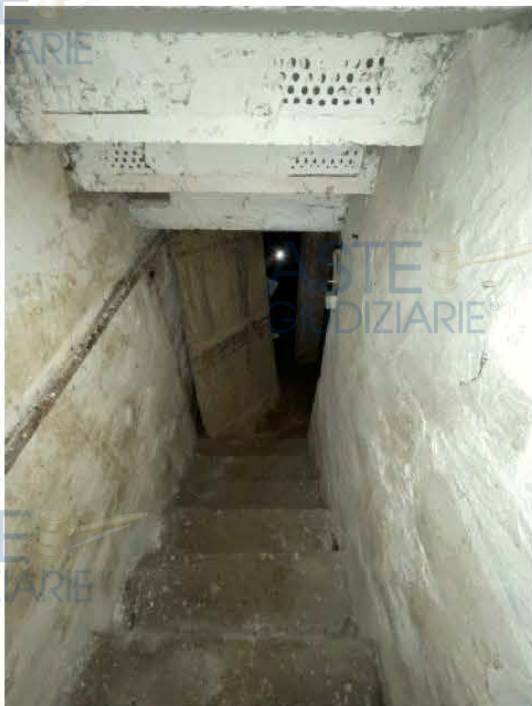
Fot. N. 19: Scala accesso alla cantina
