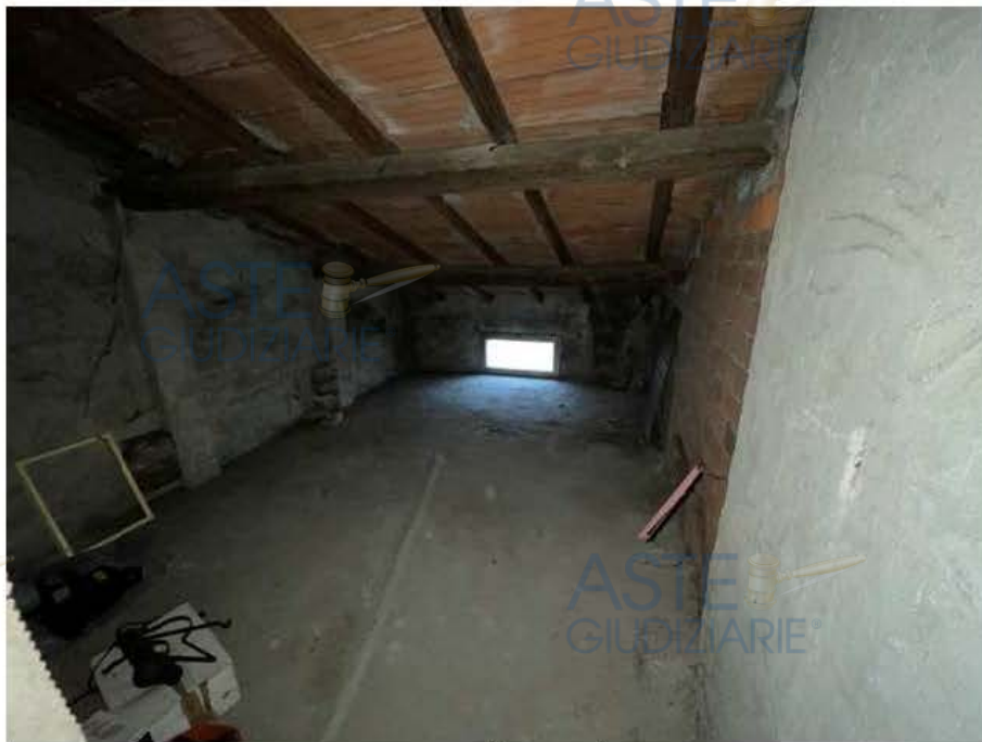
Fot. N. 17: Deposito (lato nord) – P. sottotetto
