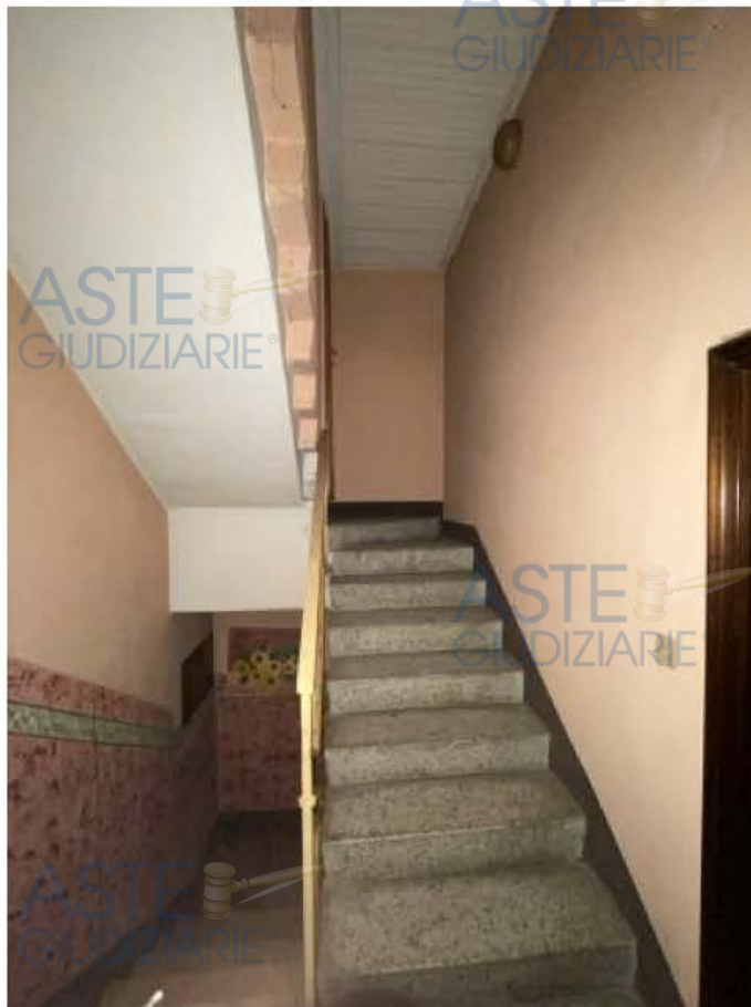
Fot. N. 15: Scala d'accesso al sottotetto – P. 1°
