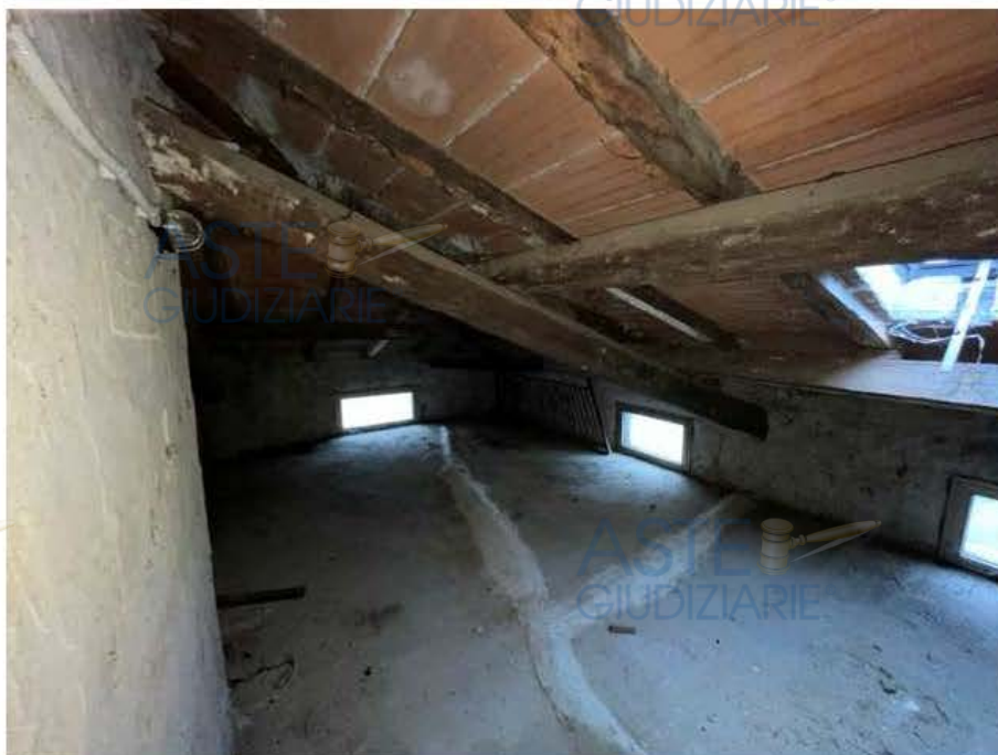
Fot. N. 16: Deposito (angolo nord/est) – P. sottotetto
