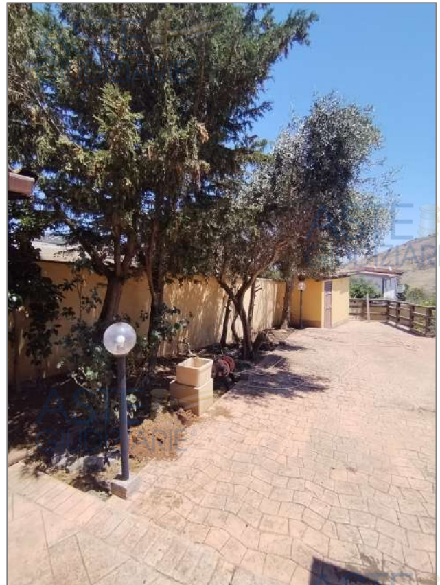
Vista del corpo accessorio adibito a servizio igienico.
