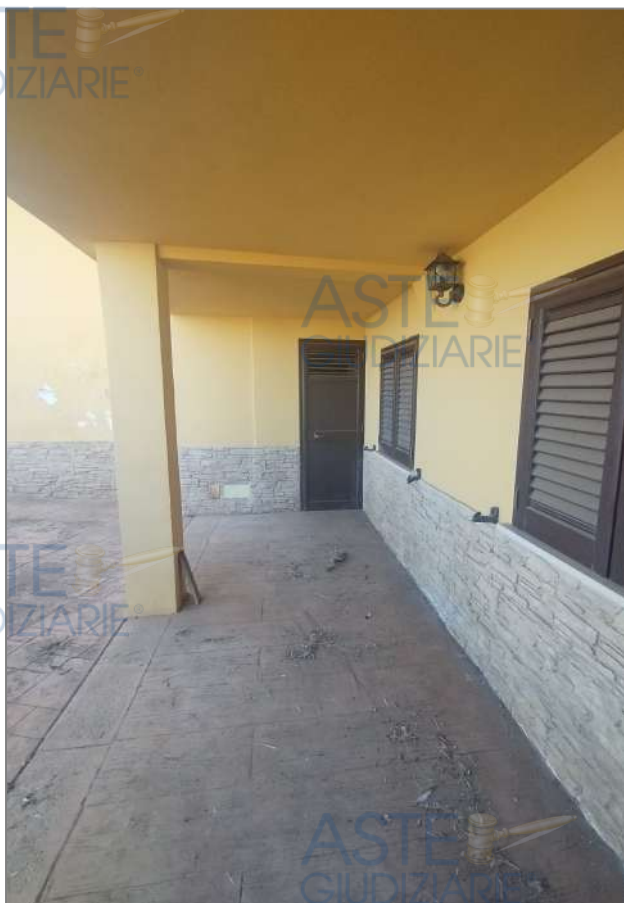
Porta di accesso alla intercapedine di ventilazione
