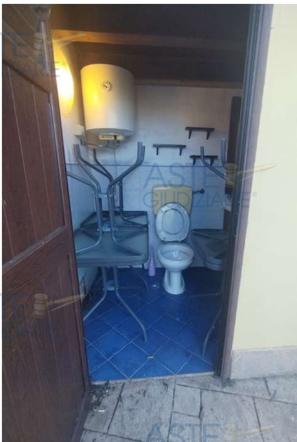
Corpo accessorio n.2. Servizio igienico.
