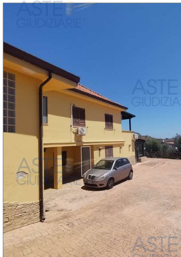
Ingresso piano seminterrato
