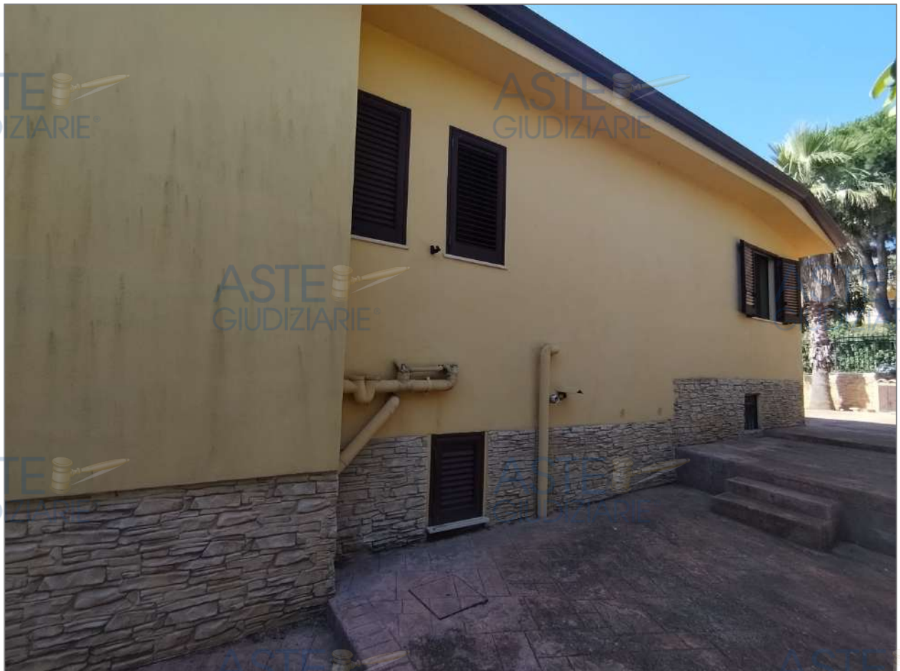
Viste del prospetto rivolto a nord-ovest.
