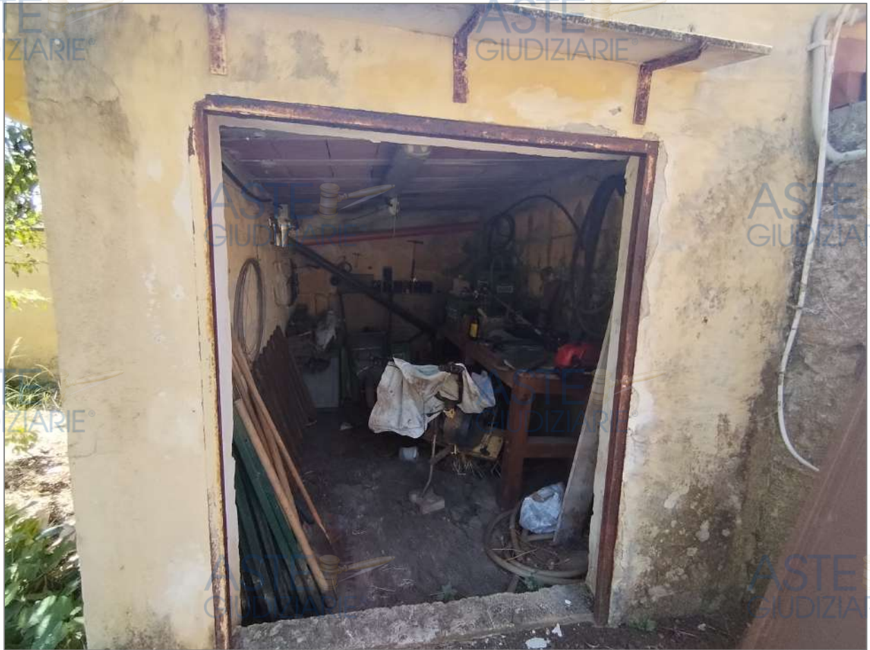
Corpo accessorio n.1. Magazzino
