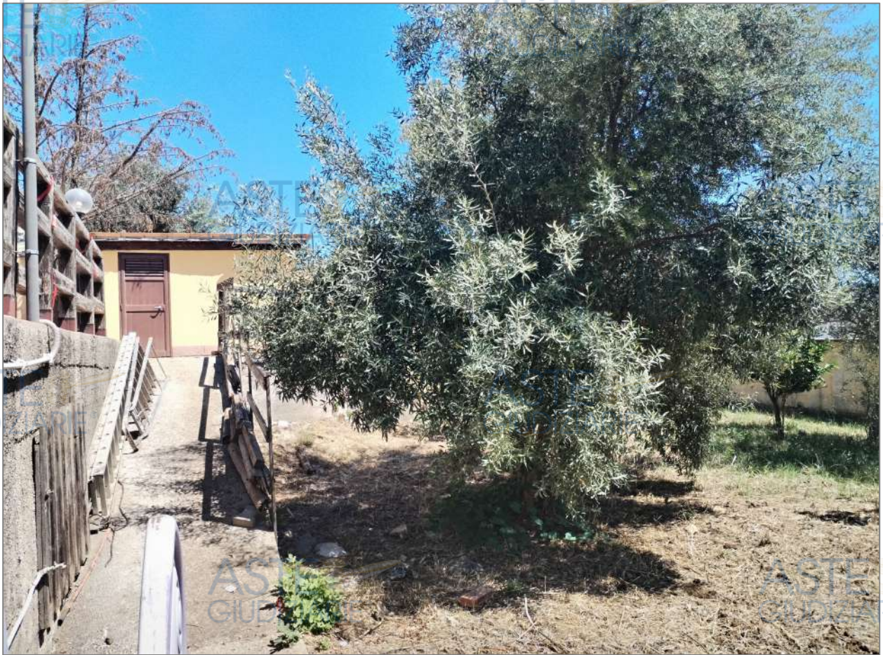
La rampa di accesso all'area a verde e sullo sfondo il corpo accessorio adibito a servizio igienico.
