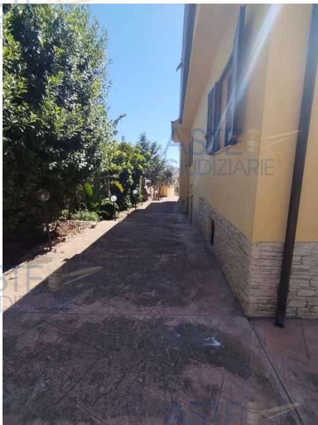
Vista del passetto dal prospetto nord-ovest.
