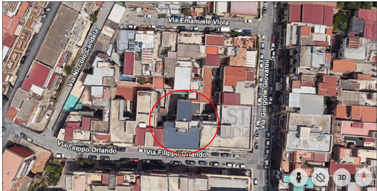
Ortofoto attuale (da Google Earth) - Individuazione del fabbricato di cui fa parte l'immobile pignorato
