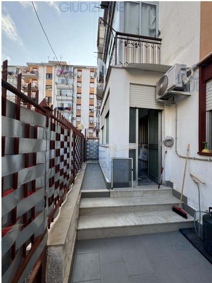
Foto 7, 8, 9 – Terrazzino esterno piano terra e veranda rialzata in cui oggi si trova la cucina. Dalla foto sopra si nota come la veranda, realizzata in muratura (quindi per questo non sanabile mediante art. 20 della LR n. 4/2003), sia sporgente rispetto al filo del balcone soprastante.
