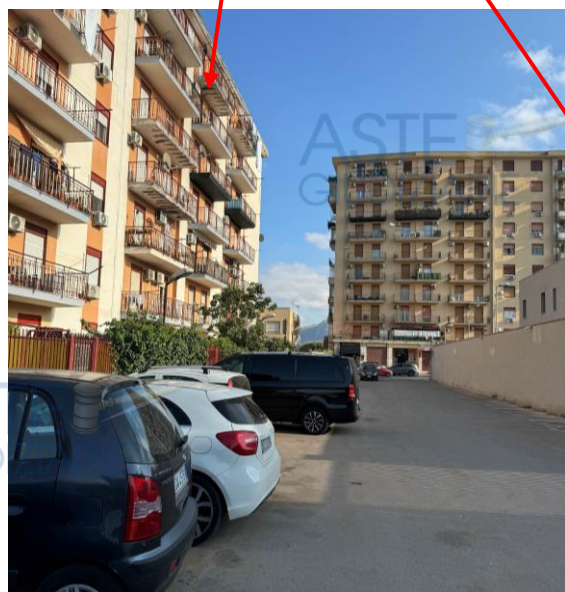
Edificio sulla via Solunto di accesso al condominio
