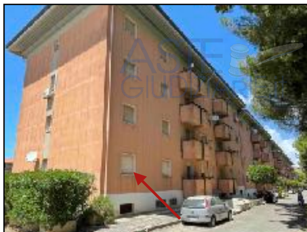
Fig.12 Fronte su via Benevento
