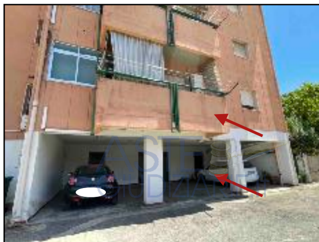
Fig.35 Appartamento e sottostante cantina
