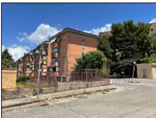
Fig.10 Testata sud-ovest del fabbricato
