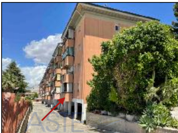
Fig.11 Fronte su via Mattarella
