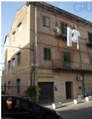
Foto n. 1 - Vista esterna edificio
