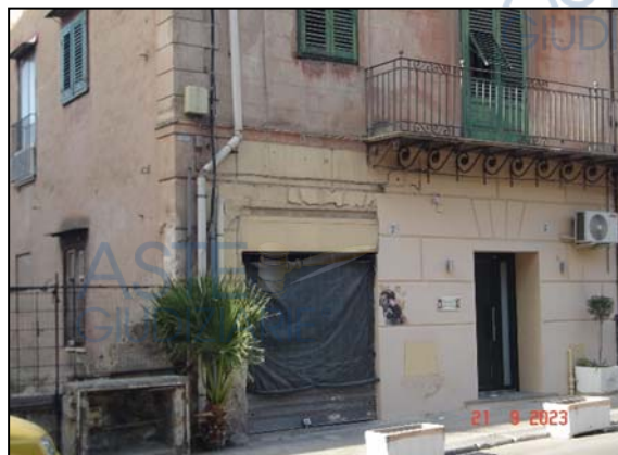
Foto n. 2 - Vista esterna edificio
