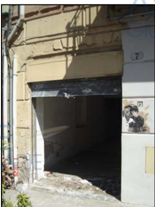
Foto n. 3 - Vista vano di ingresso
