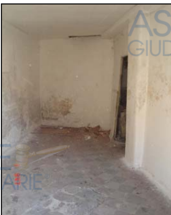
Foto n. 5 - Vista vano principale
