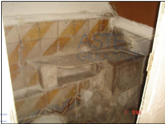
Foto n. 7 – Vista vano con w.c.
