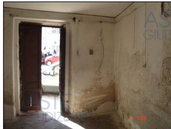
Foto n. 4 - Vista vano principale
