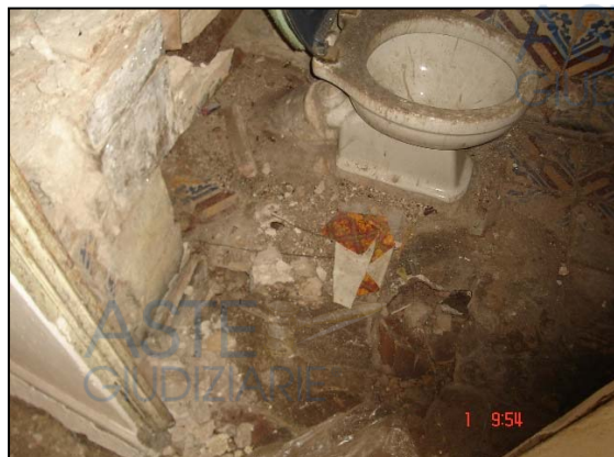
Foto n. 6 - Vista vano con w.c.
