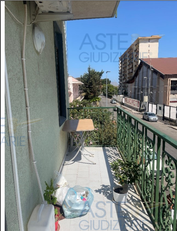
Foto n. 13 balcone prospetto principale
