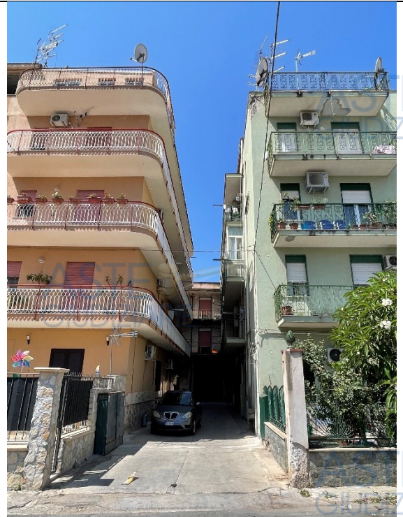
Foto n. 18 Prospetto su Via Santa Maria di Gesù
