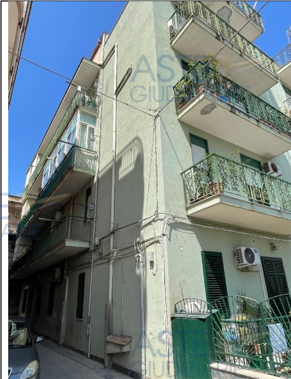
Foto n. 17 Prospetto su Via Santa Maria di Gesù
