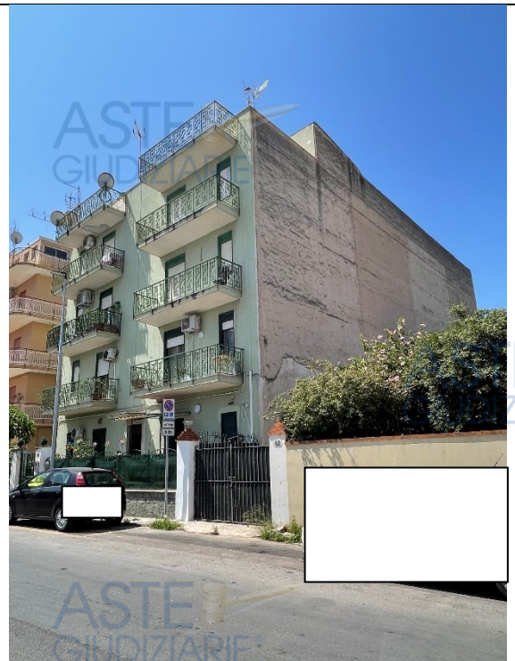
Foto n. 16 Prospetto su Via Santa Maria di Gesù
