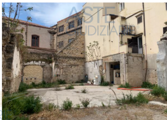
Foto 1 area in oggetto unità part.lla 839
