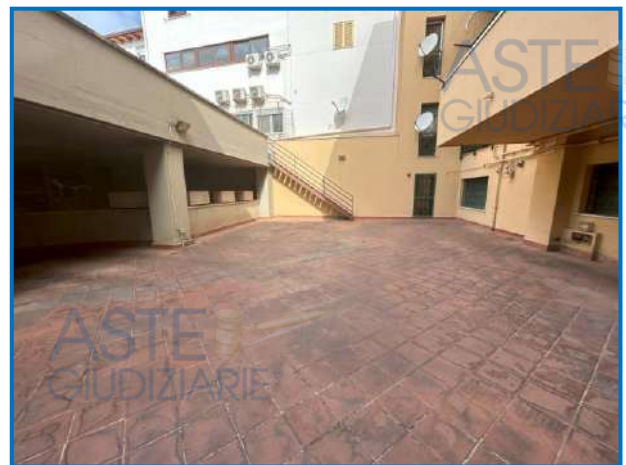
Foto n. 14 Parcheggio comune a piano Seminterrato (sub 9)
