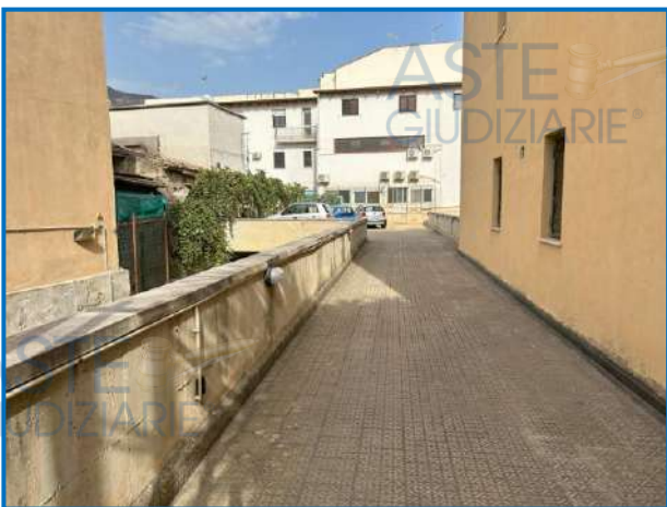
Foto n. 13 Parcheggio comune a piano terra (sub 10)
