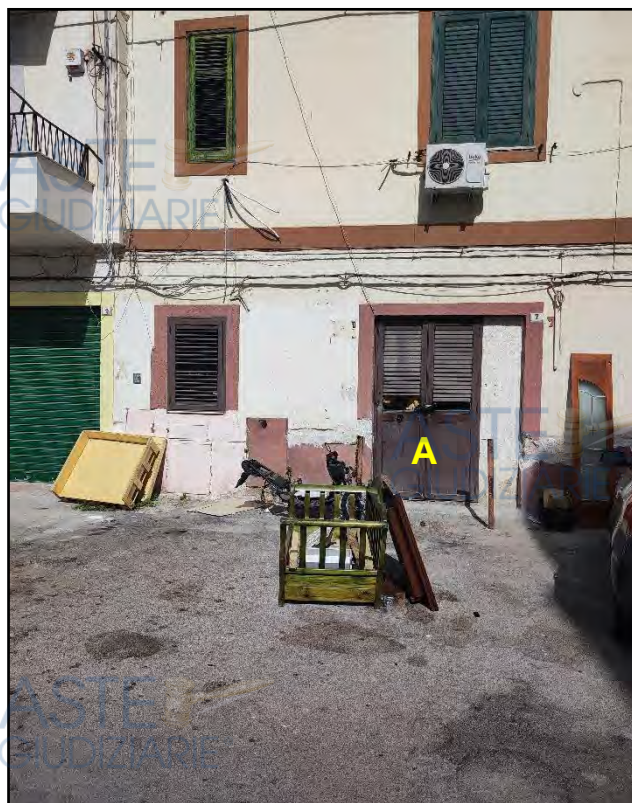
Foto N°4 - Part. accesso da Via Nervesa 7 da serramento in alluminio anodizzato a due battenti dotato di gelosie orientabili (A)
