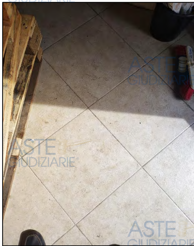
Foto N°6 - Part. pavimento in grès porcellanato (formato cm.45 x 45)
